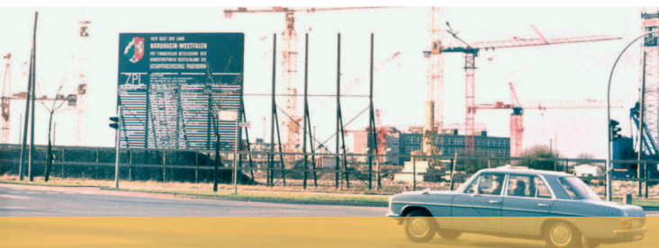
Großbaustelle an der Warburger Straße 1974
